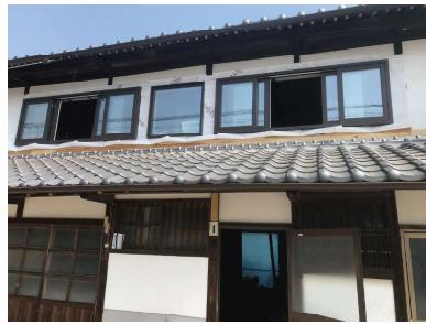
アルミの単板ガラスのサッシから、樹脂サッシで、真空トリプルガラスの高性能なサッシに変更している。
