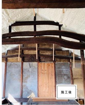
2階の天井を撤去してウレタンフォームを200mm吹き付けたところ。壁にはこの後、100ミリの高性能グラスウールを張り足している。
